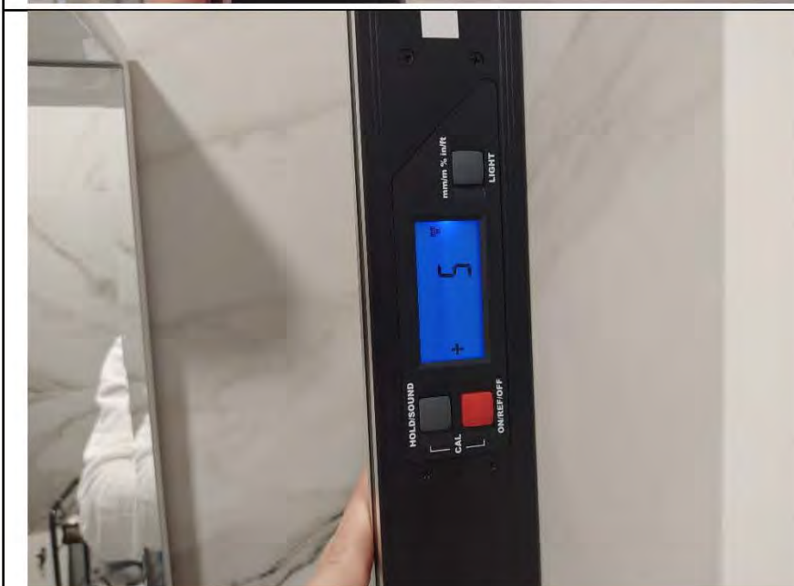
Фото №11. Измерение уровня стен в ванной комнате (керамическая плитка).
