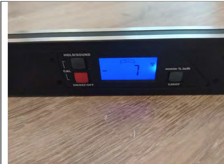
Фото №16. Измерение уровня напольного покрытия в прихожей.
