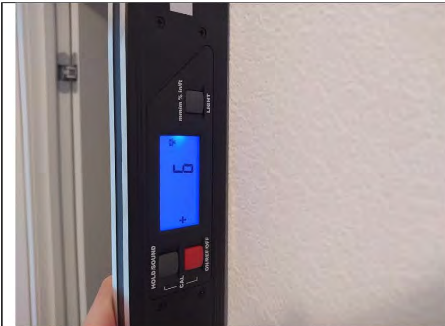
Фото №10. Измерение уровня стен в прихожей.
