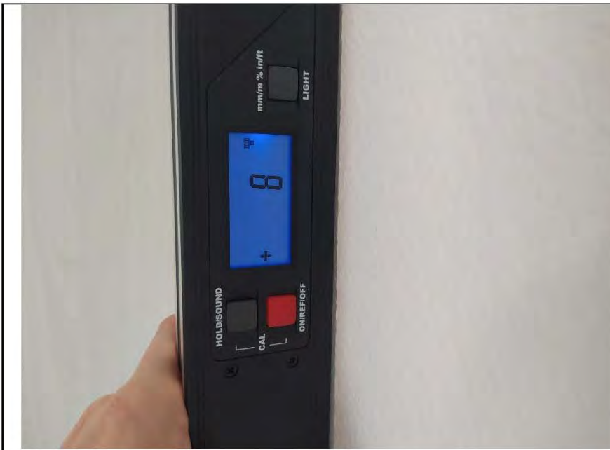
Фото №7. Измерение уровня стен в спальне.
