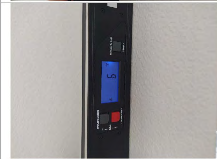
Фото №9. Измерение уровня стен в гостиной.
